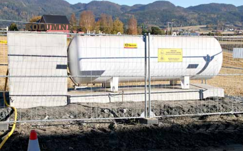
TØRKA NED 250 TONN: Gasstanken er på 4,85 kubikkmeter og var ikke tom etter at Opland hadde tørka ned 250 tonn bygg i høst. Han visste ennå ikke hvor mange kilo gass som hadde gått, da gasstanken ikke var fylt opp igjen.
